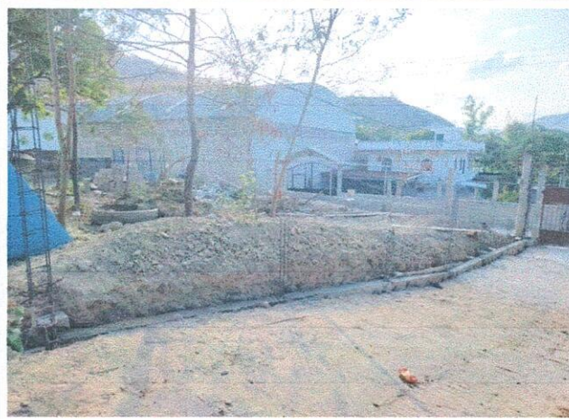
Foto 2: CERRAMIENTO MURO PERIMETRAL DEL CENTRO EDUCATIVO, EN PROCESO
