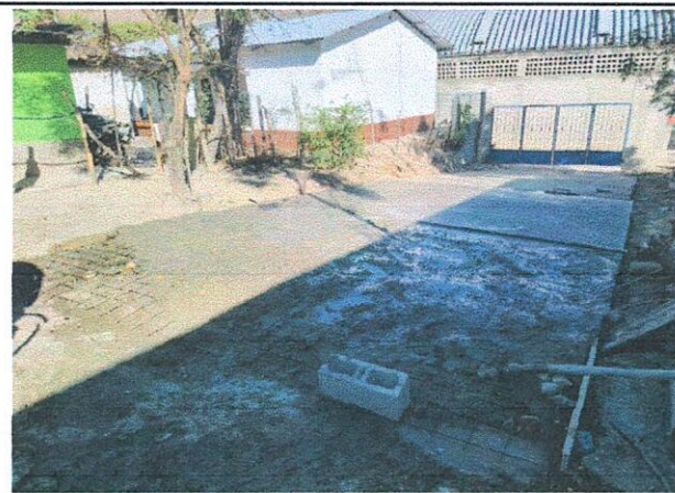
Foto 4: MEJORAMIENTO DE LOSA DE PATIO EN EL AREA DE INGRESO AL PLANTEL, EN PROCESO
