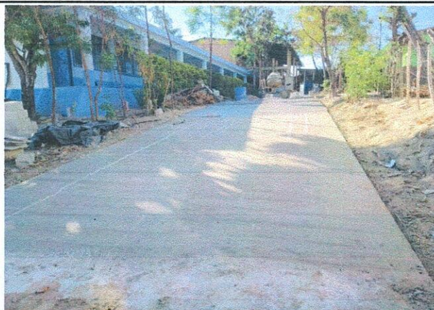
Foto 3: MEJORAMIENTO DE LOSA DE PATIO EN EL AREA DE INGRESO AL PLANTEL, EN PROCESO
